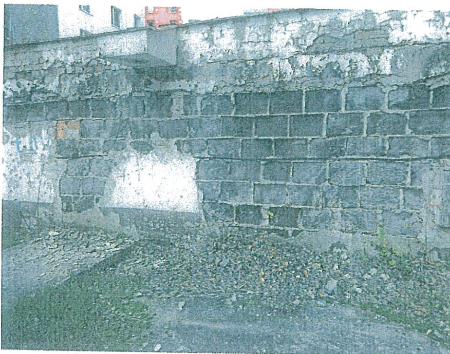
Prekrytie schodiska čiastočne degradované murivo detail . pohľad
