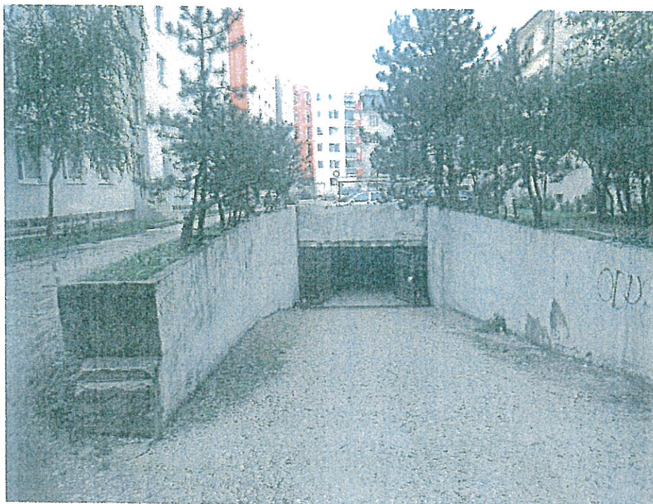
Vstup do garáží betonové zábradlie
