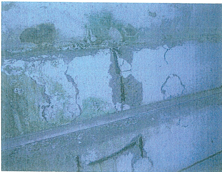
Prievlak os 8 detail odkrytej rozdeľovacej výstuže pohľad bočný
