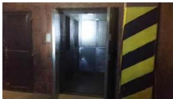
Obr. 47, 48 – Zastaralé pôvodné výťahy po hranici životnosti (rok výroby 1979)
