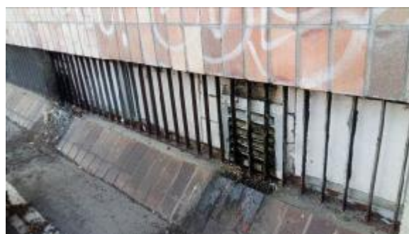
Obr.44 – Žľaby upchaté mechanickými nečistotami
