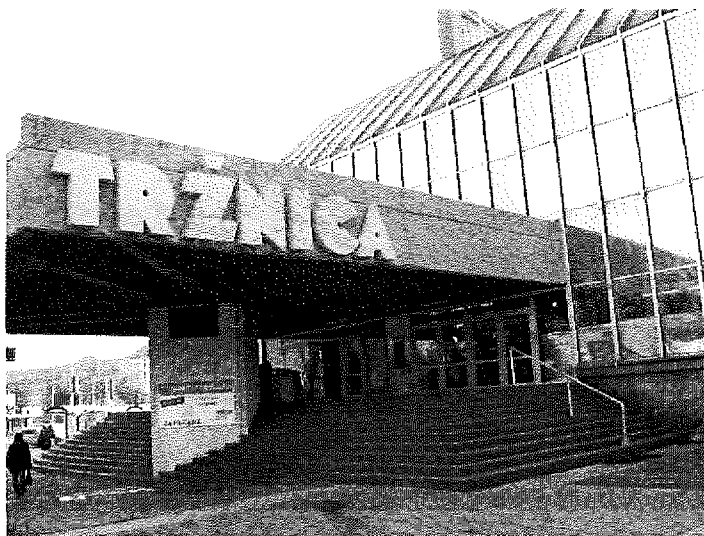
Obr. 2 – Pohľad na hlavný vstup do objektu – S/SZ
