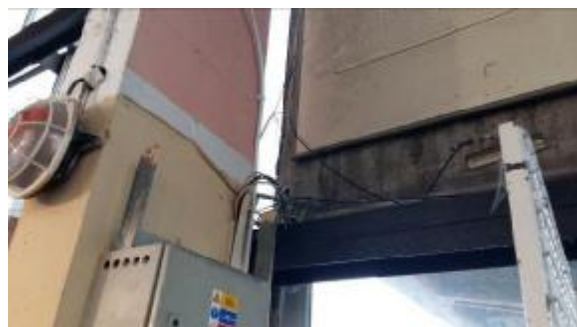
Obr.42 – Nekoncepčne dopĺňaná kabeláž bez ddokumentovania
