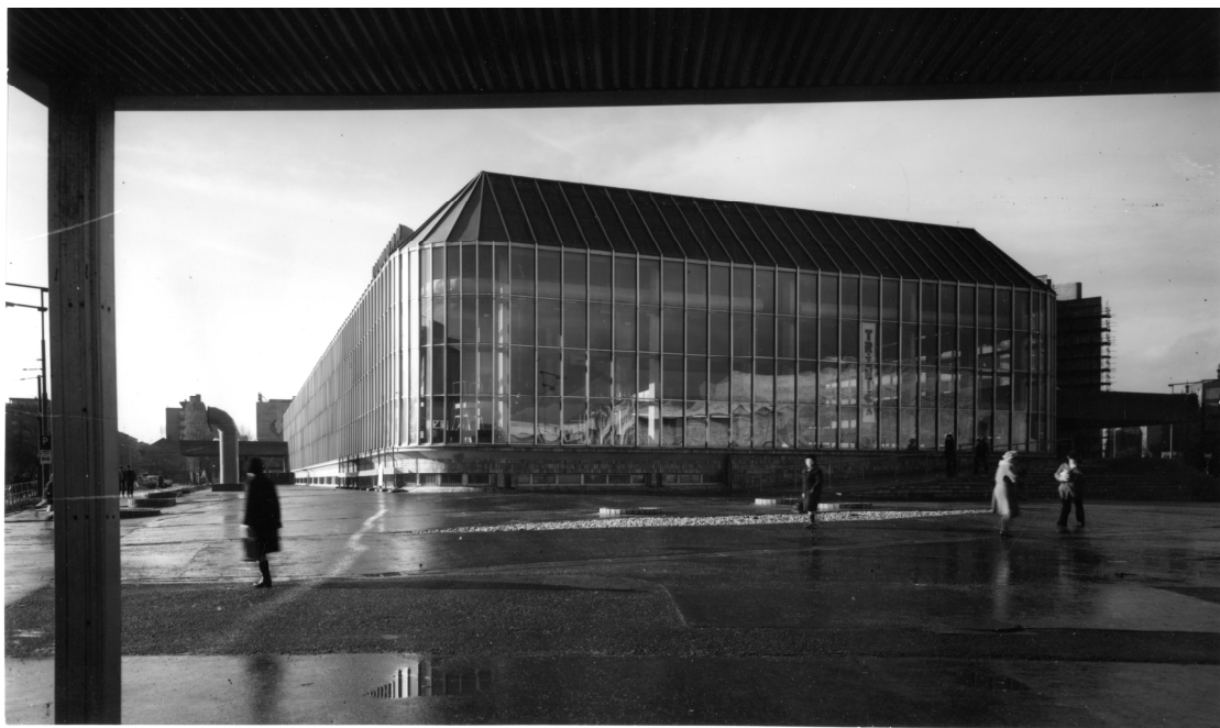
Tržnica tesne po dokončení stavby
