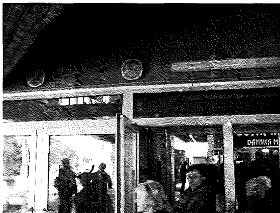
Obr. 12 – Vonkajšie osvetlenie nad vstupom do objektu
