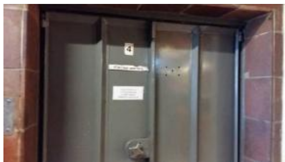
Obr. 47, 48 – Zastaralé pôvodné výťahy po hranici životnosti (rok výroby 1979)
