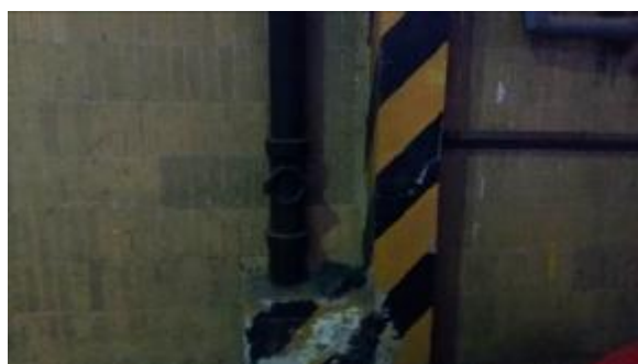
Obr.43 – Poškodená dlažba okolo upchatých žľabov
